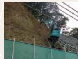
▲ロッククライミングマシン工法による掘削
