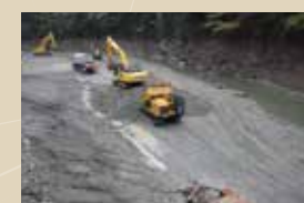
土砂掘削搬出状況
